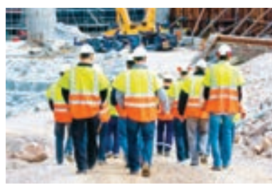
建築工地上的人 (Adobe Stock)
